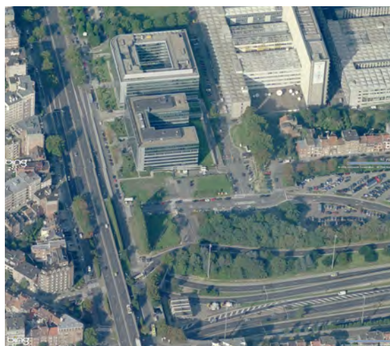
^^ Vue aérienne | Luchtfoto
