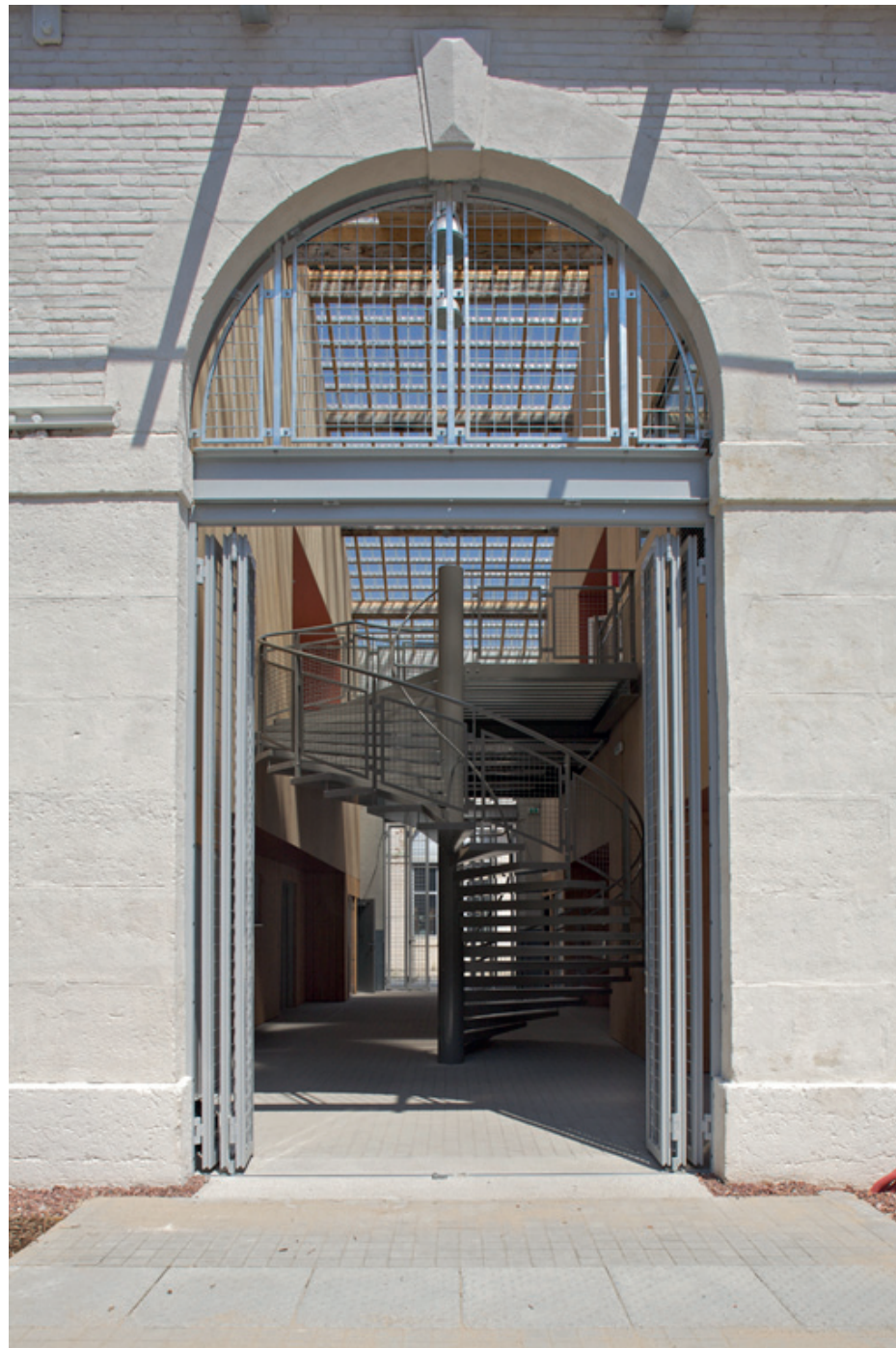
Saint-Etienne, Manufacture Plaine Achille, la Manufacture : le bâtiment de l'imprimerie transformé, un passage, 2012
